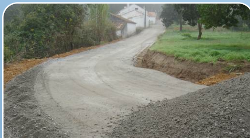
CASA NOVA DA FIGUEIRA - PAVIMENTAÇÃO
