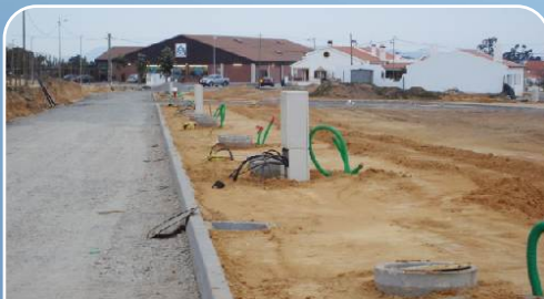
BOAVISTA DOS PINHEIROS - INFRAESTRUTURAS DO BAIRRO HABITACIONAL - 2ªFASE
